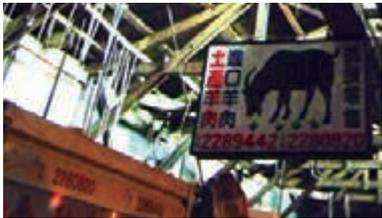
嘉義東市場的肉攤區，仰頭即可看到屋頂的木造結構，斜屋頂中央凸出的太子樓兼具採光和通風的功能，如果想要更清楚整個市場的建築形式，可從露天的三樓俯瞰。
